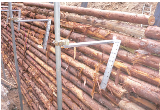
◇単管併用ブラケット足場設置完了◇
