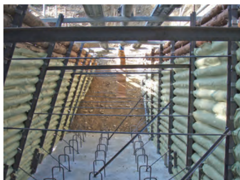
組立完了状況
