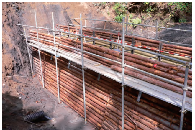
◇単管併用ブラケット足場設置完了◇
