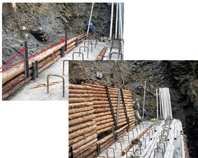
次のパネル設置
