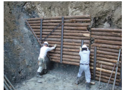
◇吊込み設置状況
