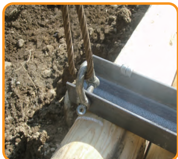
ワイヤー、シャックルにて吊込み
