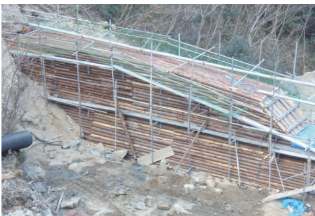
◇単管併用ブラケット足場設置完了◇
