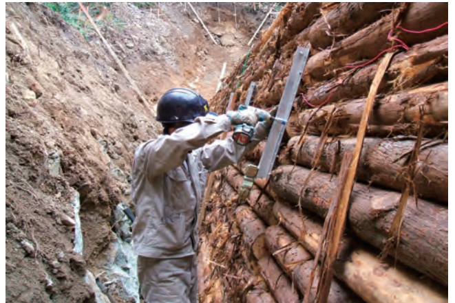
◇単管併用ブラケット足場設置状況◇
