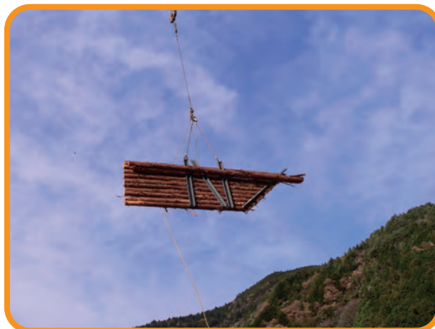
ケーブルクレーンにて
