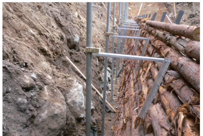
◇単管併用ブラケット足場設置完了◇
