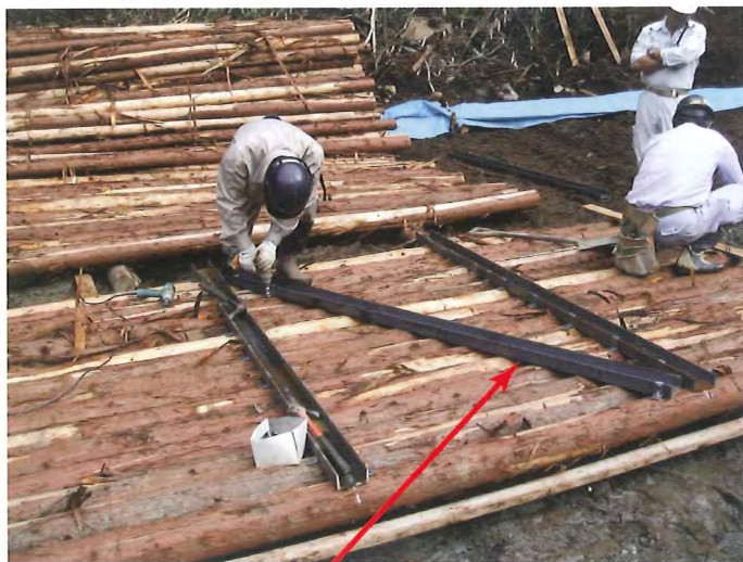
ブレス材 (吊り上げ時の歪み防止)
