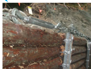
パネル同士の接続部
